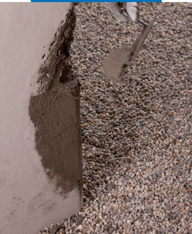
Aplikace MAPEGROUTU LM2K zednickou lžící
