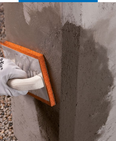
Konečná úprava houbovým hladítkem
